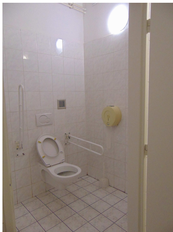
vybavení kabiny WC handicap
