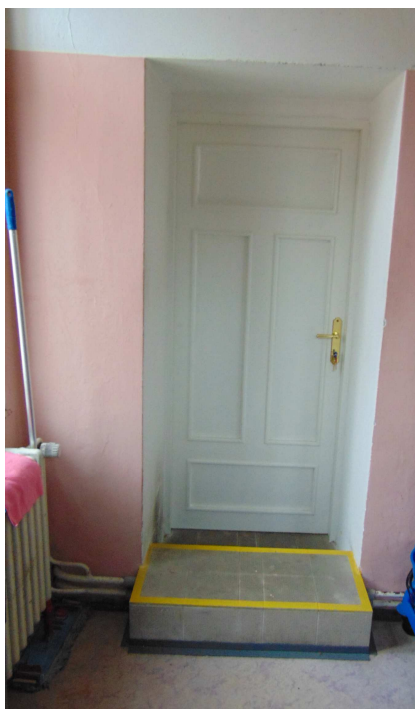
stupeň přede dveřmi-překrytí trubek ÚT-pohled z místnosti
